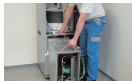
Nasunout chladicí box do tepelné centrály.
