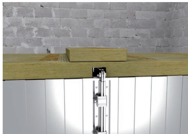
Obr. 41 Je-li použita izolační deska o tloušťce \leq 50 mm, nad přírubu se umístí pásek druhé vrstvy izolace o min. tloušťce 30 mm a šířce 150 mm
