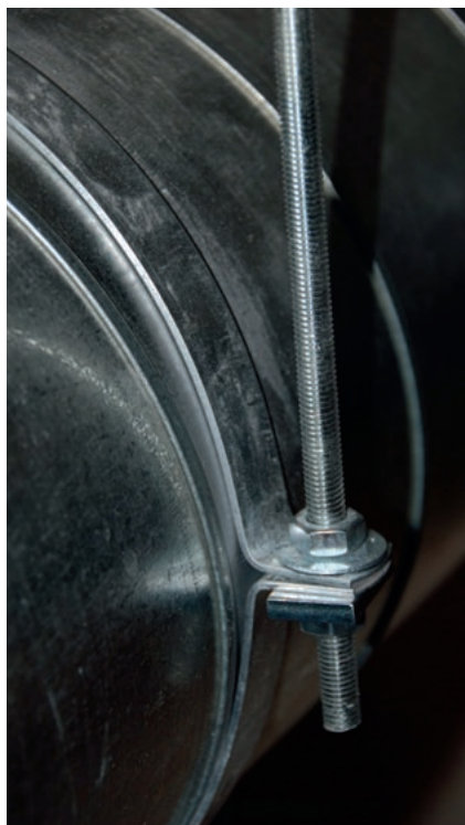
Obr. 27 Detail dvoudílné objímky pro zavěšení kruhového potrubí
