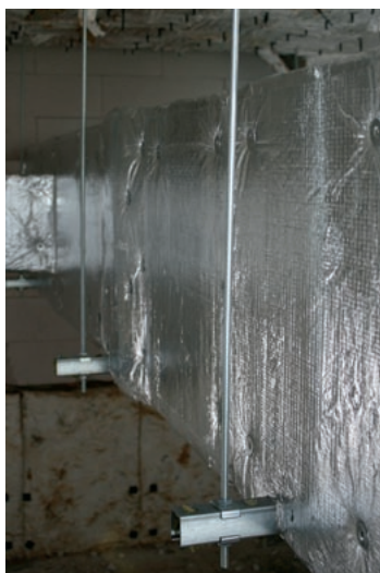
Obr. 23 Zavěšení potrubí závitovými tyčemi a instalačními profily. Na obrázku závitové tyče umístěny vně izolace (část instalačního profilu vyčnívajícího z izolace se v tomto případě neizoluje).
