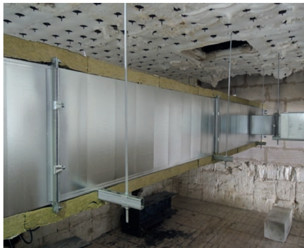
Obr. 21 Standardní jednovrstvé kladení izolace v místě přírub
