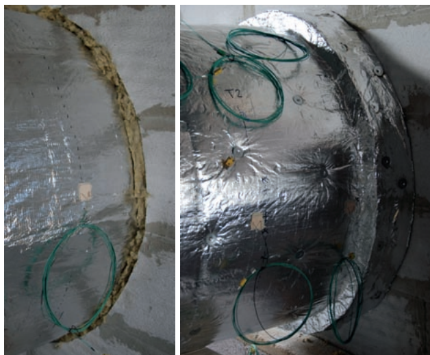
Obr. 31 Před provedením izolační manžety z druhé vrstvy lamelové rohože se nejdříve docpe meziprostor mezi izolovaným potrubím a požárně dělicí konstrukcí
