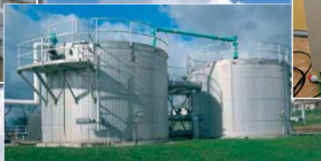
ATS - aerobní termofilní stabilizace
