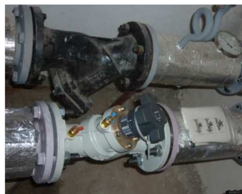
Hlavní regulátor diferenčního tlaku na vstupu
