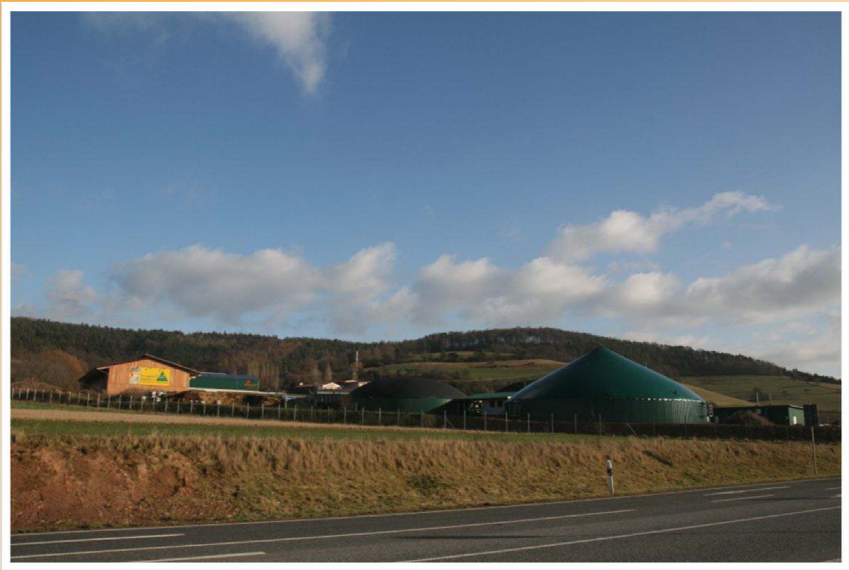
Biogasanlage „BioPower Alheim“ – Leistung 500 kwh
