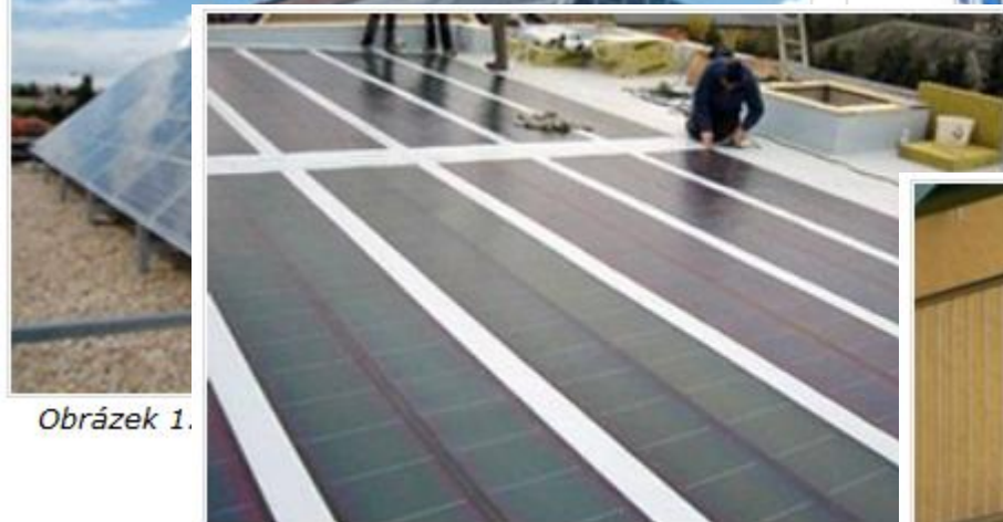
Obrázek 3: Instalace tenkovrstvé fotovoltaiky
