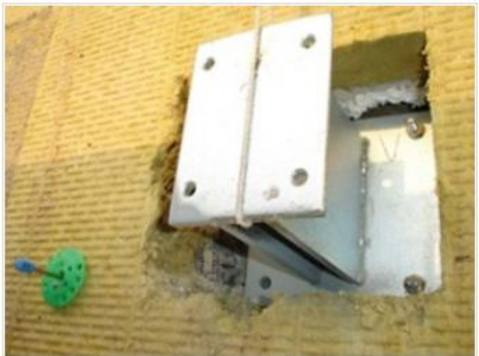
Obrázek 6: Kotva fotovoltaického systému v zateplené stěně. (ČVUT)
