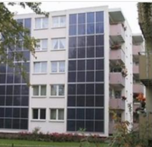
Obrázek 5: Aplikace fotovoltaických panelů na štítovou fasádu.
