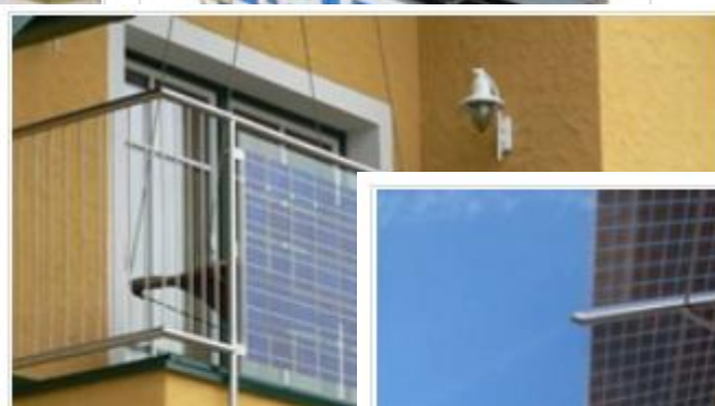
Obrázek 3: Instalace tenkovrstvé fotovoltaiky
