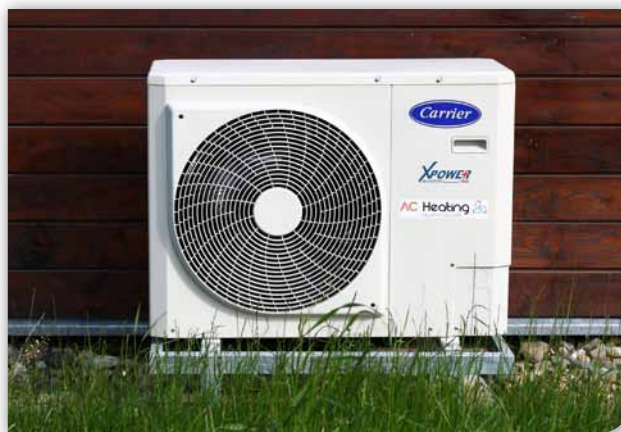
rok 2009, nízkoenergetický dům, projekt TV Nova – Dům snů, tepelné čerpadlo AC Heating Convert AW6
