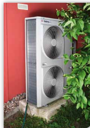
rok 2009, nízkoenergetický dům, projekt TV Nova – Dům snů, tepelné čerpadlo AC Heating Convert AW6
