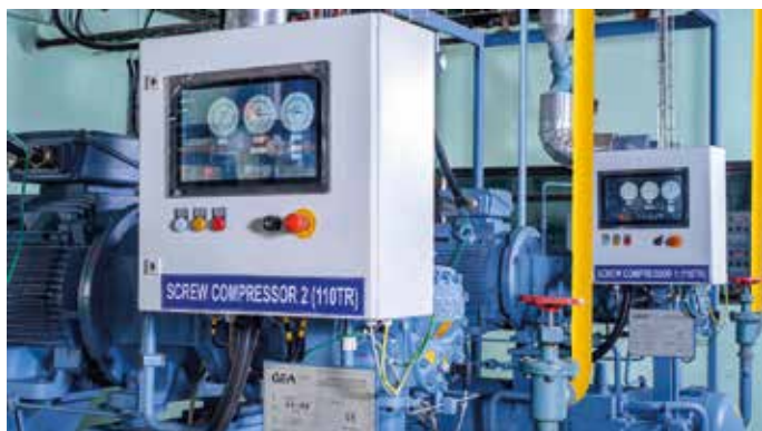
Bloková jednotka vysokorychlostního šroubového čpavkového kompresoru GEA Grasso řady M-Series 4500 RPM společnosti GEA je klíčovou součástí chladicího systému v novém závodě Fortune Dairy poblíž Pune v Indii (Foto: GEA)
