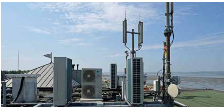
Pohled na střechu hotelu.
