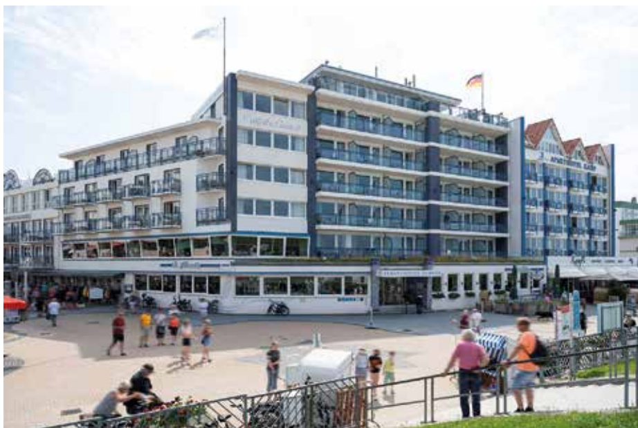
Proslulý Strandhotel Duhnen v letovisku Cuxhaven na břehu Severního moře využívá rekuperaci tepla k ohřevu hotelového bazénu.
