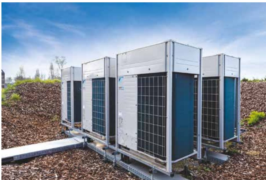
Instalace venkovních jednotek VRV 5
