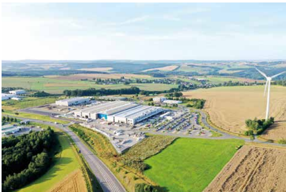
thermofin® GmbH vyrábí od roku 2003 výměníky tepla a chladicí systémy pro širokou škálu aplikací v chladicí, klimatizační a energetické technice u druhé průmyslové oblasti města Reichenbach poblíž sjezdu na dálnici A 72 (v katastru obce Heinsdorfergrund) Foto thermofin
