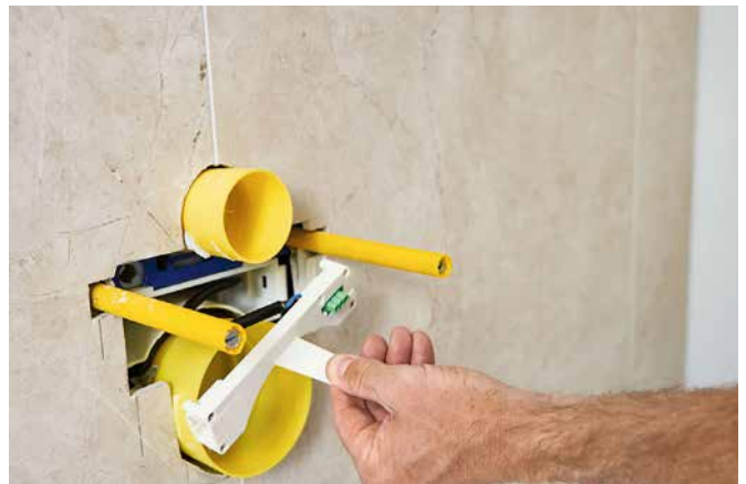
Deliacu stenu s pripojovacími svorkami pripája k sieťovému zdroju elektrikár. Všetky ďalšie montážne práce vykonáva inštalatér.
