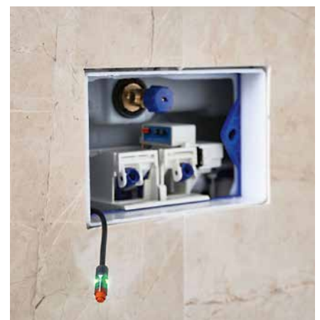
LED svetlo svieti, ak napájací zdroj funguje správne.
