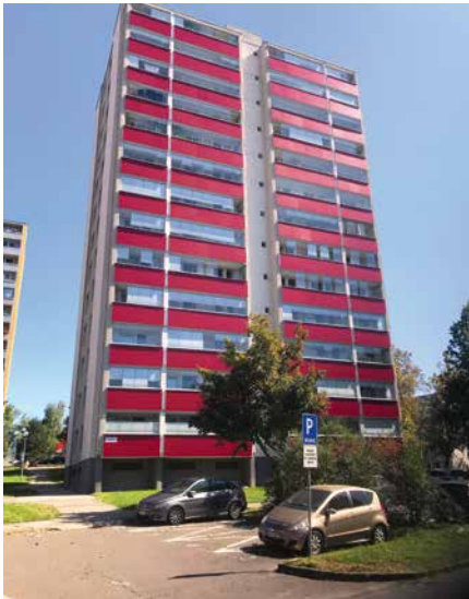
Obr. 2 Bytový dom po komplexnej obnove s komplexným dodatočným zasklením loggií v každom byte
