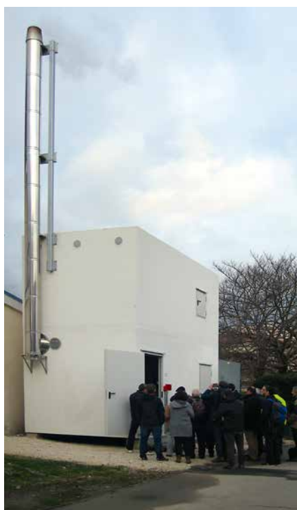
Centrálné vykurovanie komunálnymi kotolňami na biomasu, Sassenage, Francúzsko
