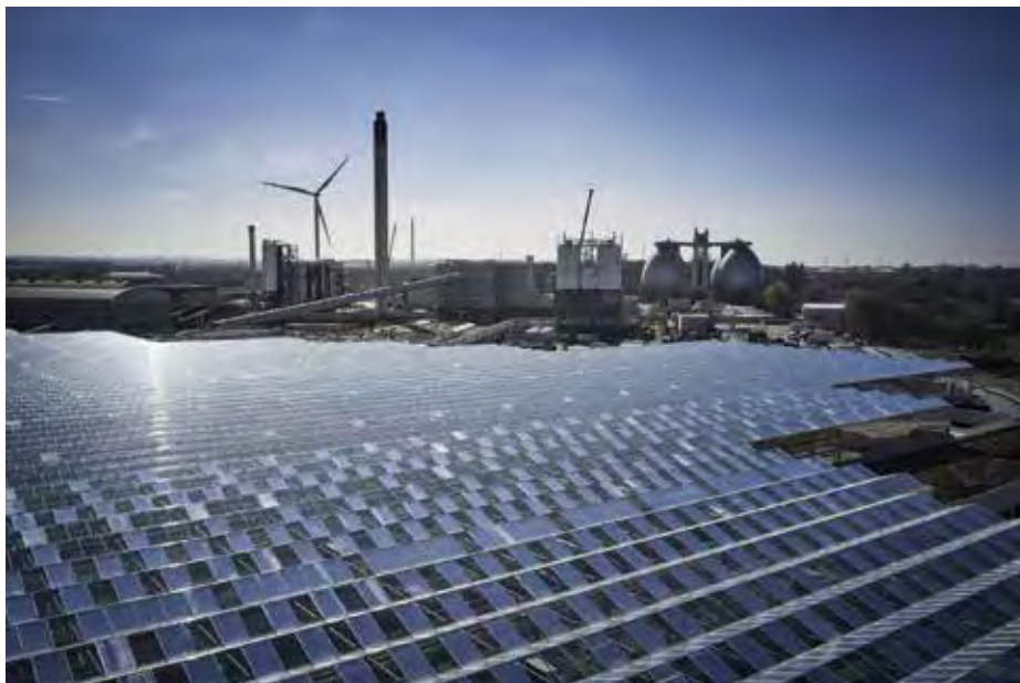
Částečný pohled na hybridní elektrárnu Emscher se skleněnými halami na sušení čistírenských kalů v popředí (foto: Viega)
