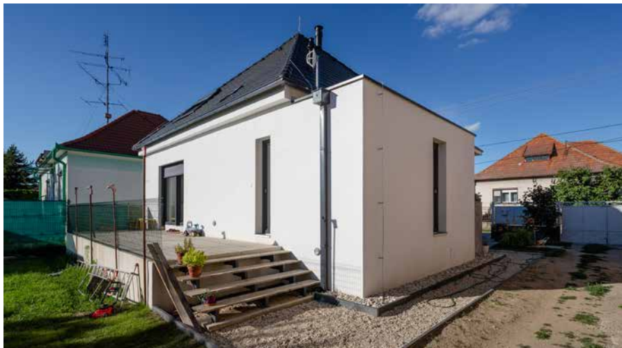
Projekt ukazuje príkladnú rekonštrukciu rodinného domu, ktorý bol postavený medzi rokmi 1966 a 1970.
