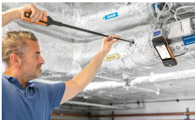
Obr. 1 Meranie objemového prietoku vo vzduchotechnickom potrubí s testo 400
