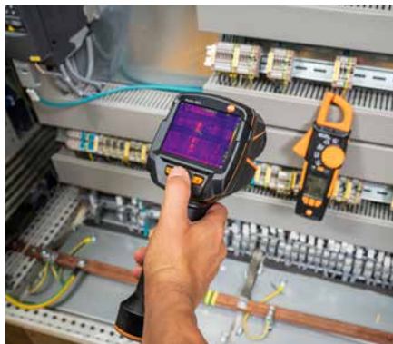
Obr. 3 Využitie kliešťového multimetra testo 770-3 pri paralelnom meraní s termokamerou testo 883
