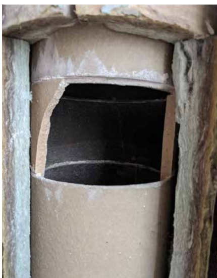
Výmena keramickej vložky
