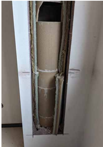
Výmena keramickej vložky
