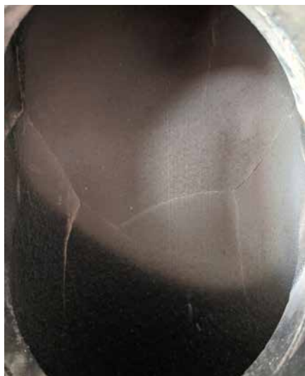
Popraskanie keramickej komínovej vložky spôsobí znehodnotenie komína.
