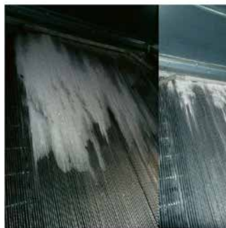
Obr. 4 Ukážka namrzania výmenníka SZT (vľavo), grafická definícia výpočtu SZT v H-X diagrame (vpravo)
