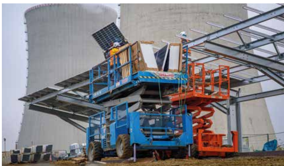
Výstavba parkoviště zastřešeného oboustrannými fotovoltaickými panely v Jaderné elektrárně Dukovany
