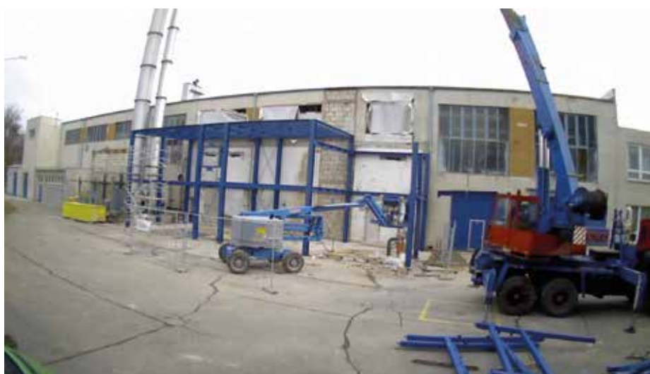
Obr. 4: Probíhající staoba nástavby pro umístění technologických částí zkušebny (SZÚ Brno)
