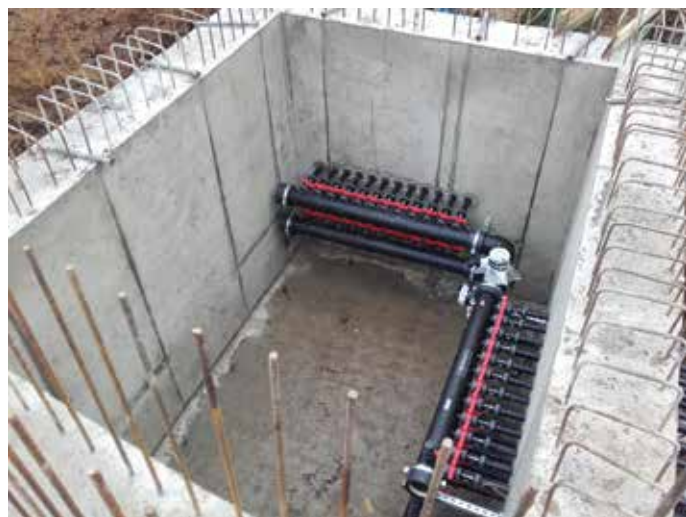
Atypický rozdělovač/sběrač GEROtherm BASIC v monolitické sběrné jímkce
