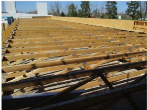
Ošetřené příhradové vazníky objektů záchranné a požární techniky, Letecká základna Čáslav
