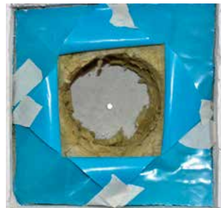
Obr. 8: Prostup stěnou po odstranění tepelné izolace. Důležité je, aby střed prostupu byl pevně určen i ve vnitřní sádrokartonové desce, pokud má být při instalaci větrací jednotky konstrukce stěny co nejméně narušena.
