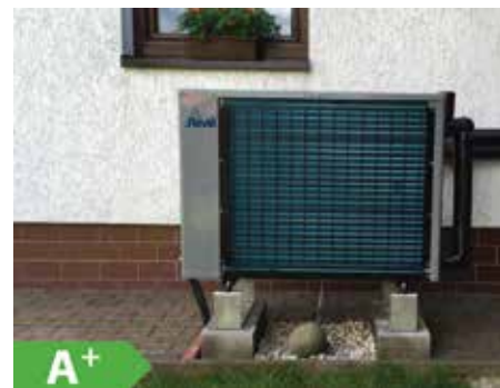
Provedení A – Ventilátorem ke stěně – doporučená vzdálenost od stěny (za jednotkou) 250 mm
