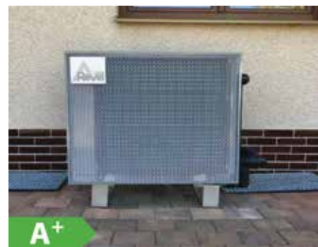
Provedení B – Ventilátorem ke stěně s ochranou proti krupobití – doporučená vzdálenost od stěny (za jednotkou) 250 mm a od terénu min. 150 mm
