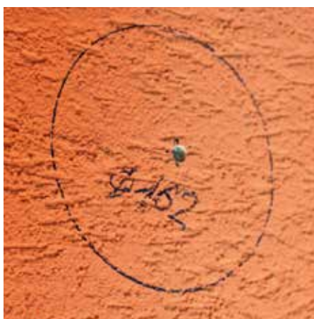
Obr. 9: Toto považuji za velmi důležité. Otvor po ortáku určuje střed pro zhotovení prostupu stěnou zoenku.
