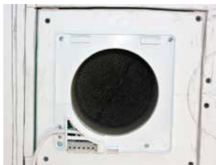
Obr. 20: Elektrické napájení větrací jednotky jsem se nakonec rozhodl provést co nejjednodušeji, a to volným kabelem do elektrické zásuvky. Na obrázku již byly do konstrukční trubky vloženy všechny části a vidět je pouze černý filtr.
