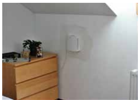
Obr. 22: Po zčištění sádrokartonu byla na vnitřní rám větrací jednotky upevněna vícestanná vyústka zajišťující nasávání a vydechování vzduchu v různých směrech do místnosti.
