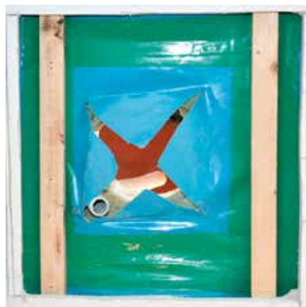
Obr. 13: Podložní latky byly velmi opatrně zasunuty mezi interiérový sádrokarton a parotěsnou fólii.
