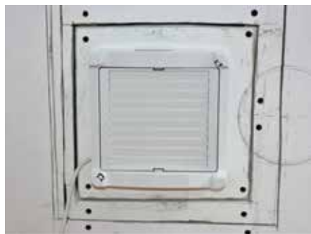
Obr. 21: Pohled z interiéru před konečnou úpravou.
