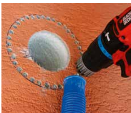
Obr. 10: Udržet v ruce ortáčku s jádrovým ortákem o průměru 160 mm, aniž bych poškodil povrch fasády a dodržel střed ortání, jsem si netroufl. Zoolil jsem zdlouhavější, ale pro mne jistější postup.
