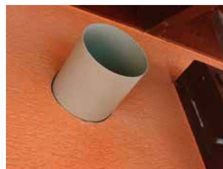
Obr. 14: Pohled na fasádu s prostrčenou trubkou tělesa decentrální větrací jednotky.
