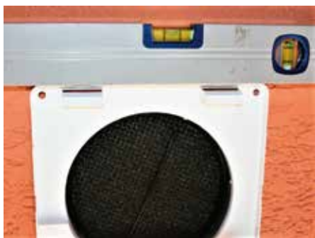
Obr. 18: Vyrovnaní do vodorovné roviny a upevnění na fasádu bylo samozřejmostí.
