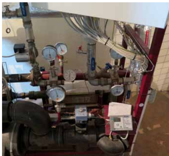
Obr. 4 Tvarovky z temperované litiny v soustavě vnitřního vodovodu z PPR
