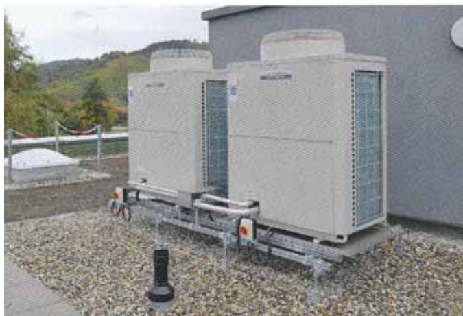
U inovativních zařízení s technologií „VRF“ se spoléhá na rozdělení konstrukce výměníku tepla, s cílem zajistit nepřerušovanou dodávku tepla
