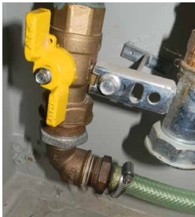
Obr. 10 Detailní pohled na místo provedení připojení zahradní plastové hadice
