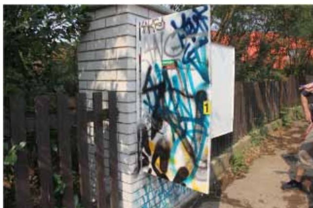
Obr. 7 Celkový pohled na objekt skříňe
