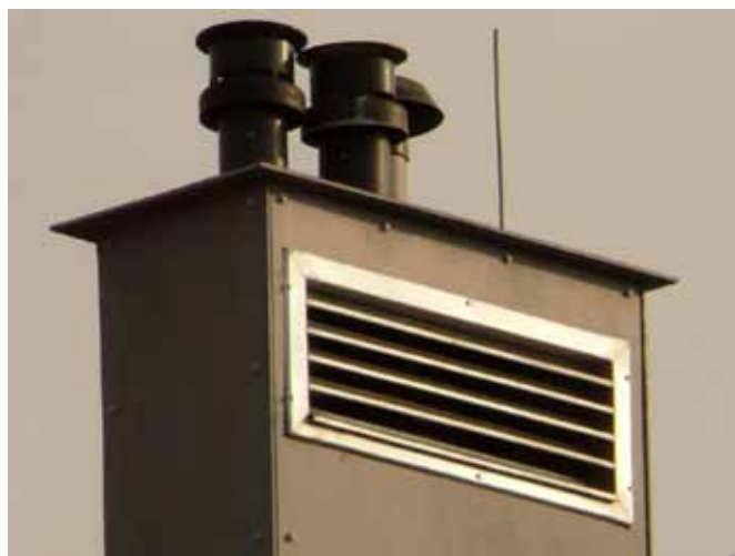
Obr. 5 Celkový pohled na konstrukci šachty s vyústěním odvodů spalin
