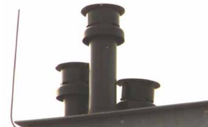
Obr. 4 Pohled na provedené vyústění – střední vyšší vyústění nasává spaliny od levého a pravého vyústění
