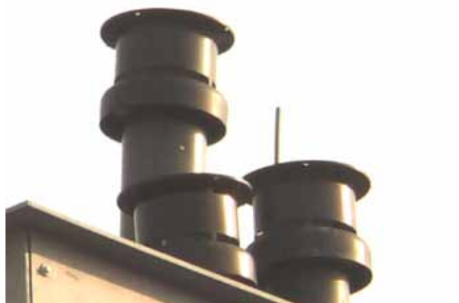
Obr. 3 Pohled na provedení vyústění – v pozadí vyšší vyústění nasává spaliny od dvou před ním vyústěných odvodů
