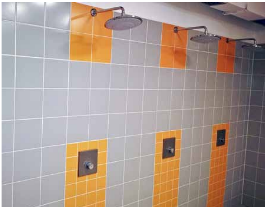
Pohled do zázemí Sportovního centra Hotelu Olšanka v Praze s podomítkovými sprchovými armaturami Schell Linus D-SC-M
