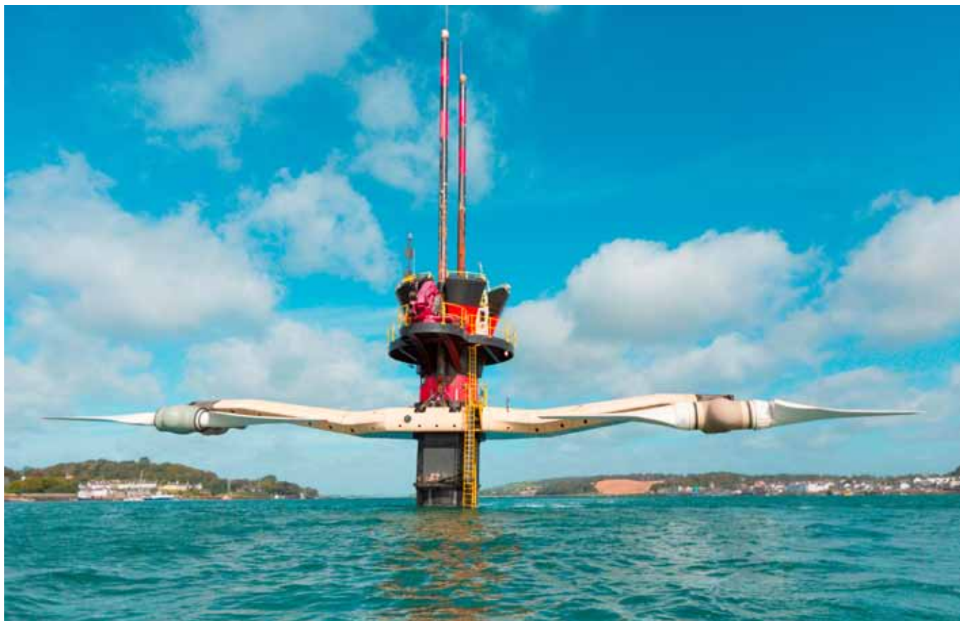
Oba rotory stávající turbíny Seagen jsou navzdory své velikosti (průměr otáčení je 16 metrů) značně pohyblivé a zároveň jsou schopny rotace v rozsahu 180°, díky čemuž může turbína vyrábět energii během přílivu i odlivu. Pro snazší údržbu lze zařízení vytáhnout nad hladinu
