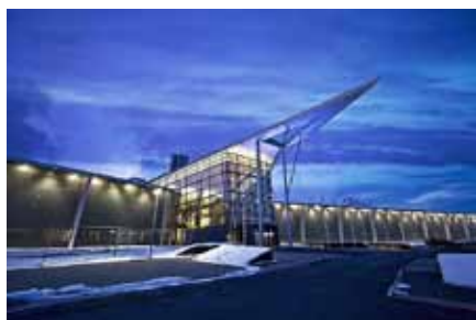
Největší islandská elektrárna Hellisheidi (303 MWe a 133 MW tepla) čerpá energii z 50 vrtů (projektovala Mannvit Engineering)
