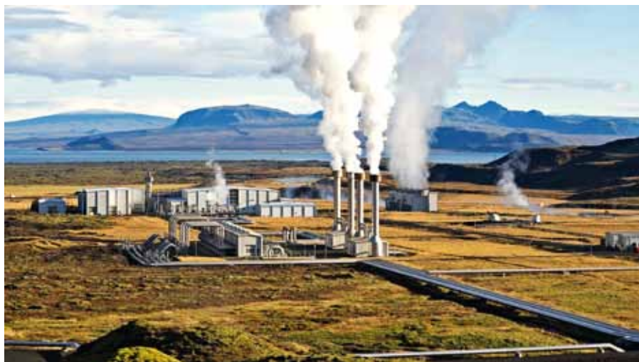
Islandská elektrárna Nesjavellir zásobuje islandskou elektrosíť 120 MWe a teplárenskou síť 1800 litry vody 83 °C horké za sekundu
