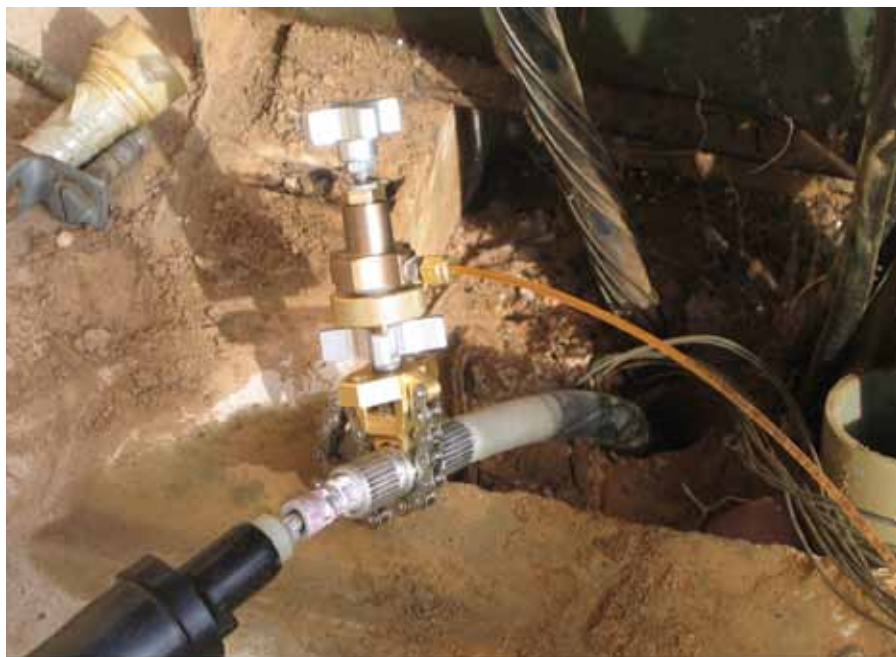
Pro novou metodu renovace kabelů je – kromě samotné silikonové směsi – potřeba v podstatě už jen pumpa se speciálním nástavcem, která vrhá směs do kabelů
