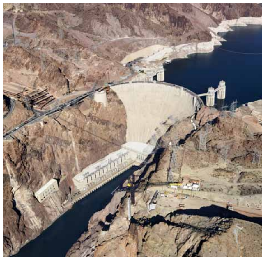
Hráz vědného objektu hollywoodských filmařů, známé Hooverovy přehrady na řece Colorado, měří 220 m; Jinping-I má hráze stejného typu, je však o polovinu vyšší, a dosahuje tak výšky Eiffelovy věže, samotné turbíny budou pracovat v hloubce 230 m
