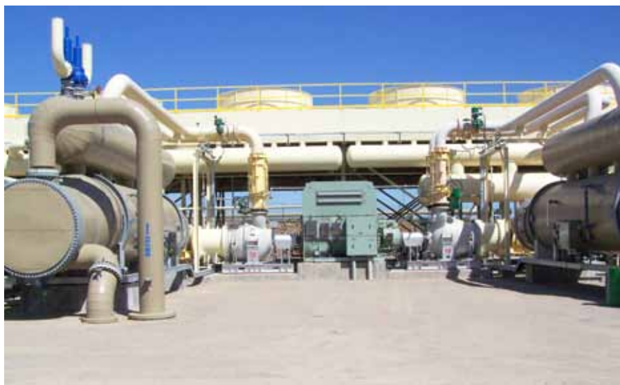
Otevřený kondenzátorový úsek strojovny geotermální elektrárny Ornat s výkonem 120 MW na Filipínách
