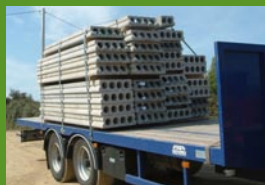
Příjezd na stavbu T + 0 minut
