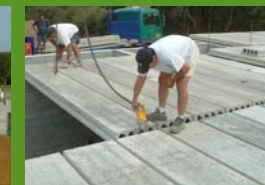
Dokončení pokládky T + 60 minut
