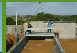
Pokládka prvních panelů T + 32 minut
