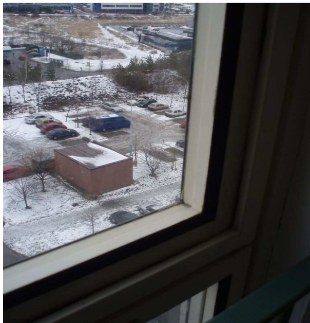
Obrázek 5: Dřevěné zdvojené okno na chodbě objektu.
