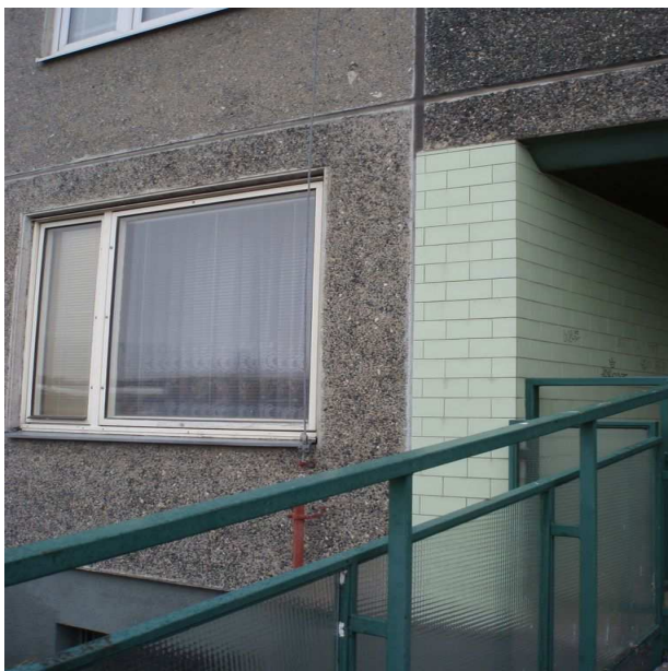
Obrázek 6: Obklad boční stěny průchodu.
