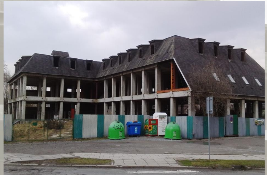
POHLED NA BF Z UL.HLUČÍNSKÁ
