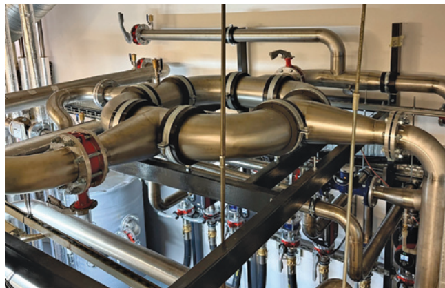
Obr. 3 Realizace hydraulického věnce ve strojovně na základě PD v 3D modelu.
