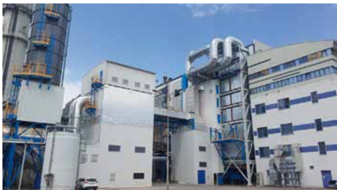
Teplárna České Budějovice, 2. pilíř dekarbonizace – retrofit kotle K12 na biomasu. Zdroj: Teplárenské sdružení ČR
