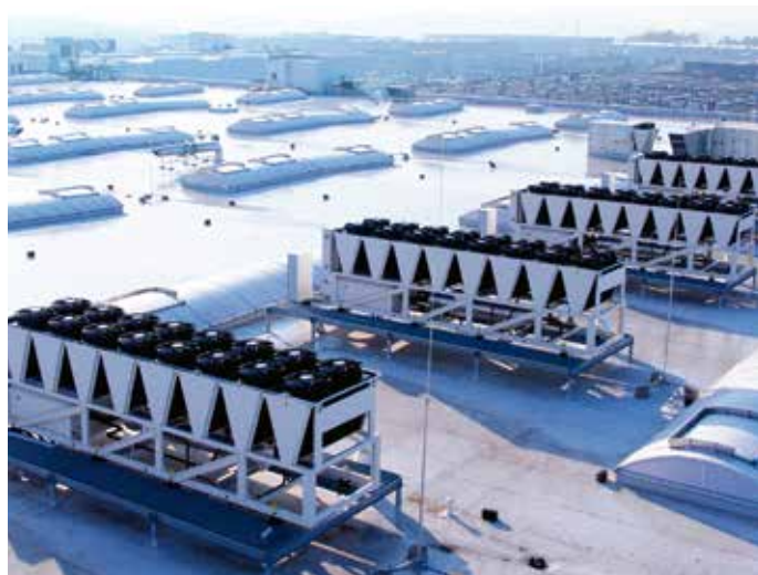
„Střešní krajina“ plzeňského výrobního areálu)
