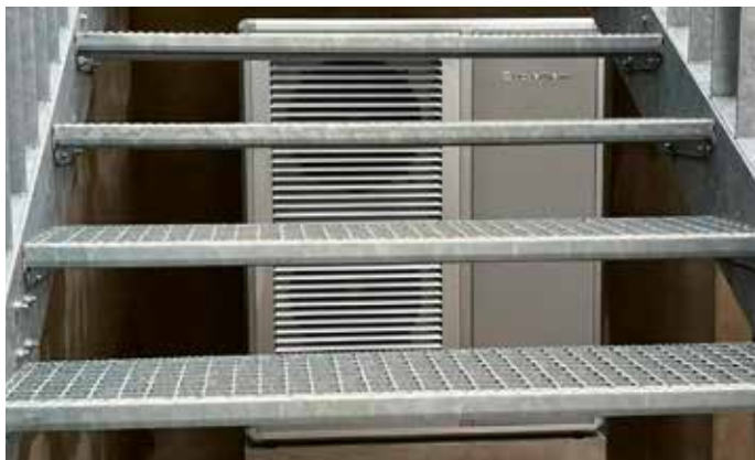
Vytápění cukrárny a rodinného domu v Krušných horách
