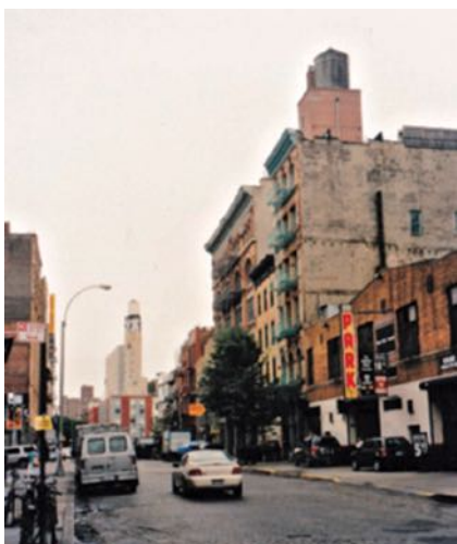
Obr. 3 New York – vodojemy 2
