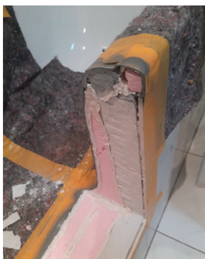
Obr. 8 Výplň dutin a tmelení dutin
