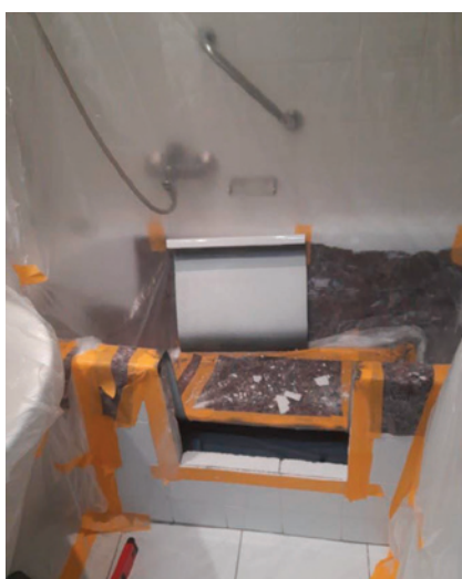
Obr. 7 Vyříznutí otvoru
