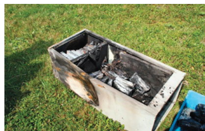
Kriminalistické ohnisko (bateriové úložiště)
