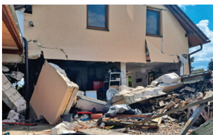
Západní pohled na objekt – detail
