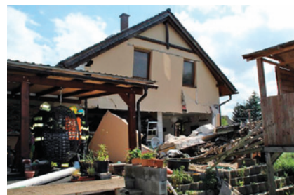
Pohled na severní stranu objektu (střeša s FVE panely)
