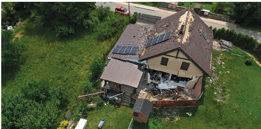
Přehledová situační fotografie poškozeného objektu
