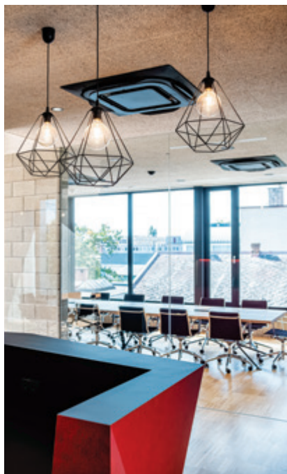
Vnitřní stropní kazetové jednotky s kruhovým výdechem a dekoračním panelem v černé barvě
