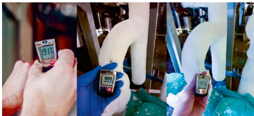
Obr. 6 Aplikace reflexního termoizolačního nátěru průmyslového rozvodu horké vody
