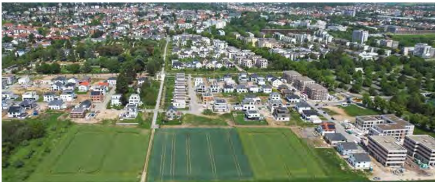
Pohled z ptáčích perspektivy na novou zástavbu v Bad Nauheimu: Na zemědělské půdě v popředí je v hloubce jeden a půl a tři metry umístěn dvouvrstvý kolektorový systém studeného dálkového vytápění (zweiflagige Kollektoranlage des kalten Nahwärmernetzes)
