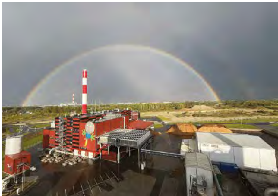
Energetický komplex Utilitas Vão využívá vysoce účinnou kogenerační jednotku na biomasu a čtyři tepelná čerpadla od společnosti GEA, která využívají odpadní teplo z kogenerace, k dálkovému vytápění přibližně 8000 domácností a podniků v estonském hlavním městě Tallinnu (Foto: AS Utilitas)
