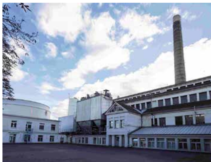
Teplárna ve čtvrti Neukölln v rámci projektu „ekologicko-sociální energetické změny“ (ökologisch-soziale Energiewende) usadila na dvě velká tepelná čerpadla GEA (Foto: GEA/ Cem Yüceltas)
