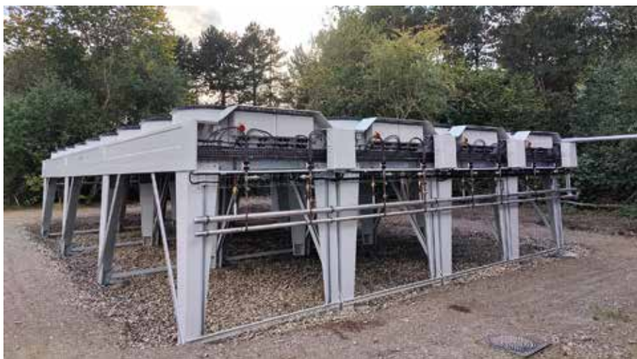
Čtyři blokové suché výparníky TEHHP CO 2 DX, každý s 18 EC ventilátory (9 + 9 v řadě za sebou) jako součást tepelného čerpadla s chladivem CO 2 (Vier thermofin Wärmepumpenverdampfer TEHHP für CO 2 DX mit je 18 EC-Ventilatoren)
