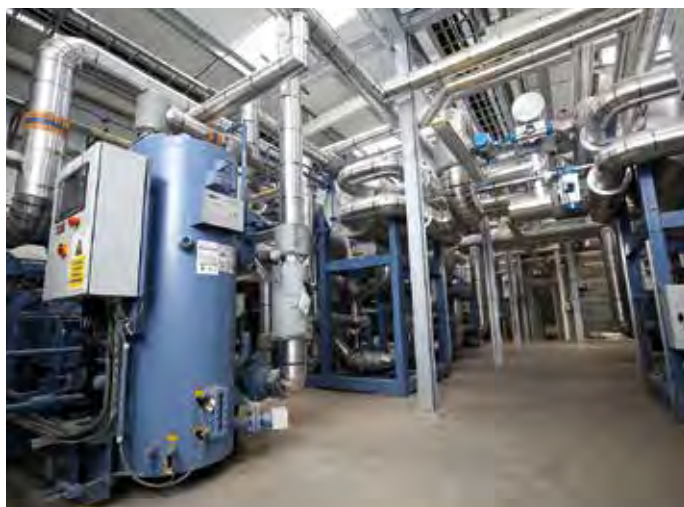
GEA je na špici technologických řešení pro boj se změnou klimatu a pro zásobování projektů dálkového vytápění, jako právě tento v severovýchodní Anglii. Tepelná čerpadla GEA jsou jádrem programu Gateshead Mine Water Scheme, největšího systému rekuperace tepla důlní vody ve Velké Británii (Foto: GEA)
