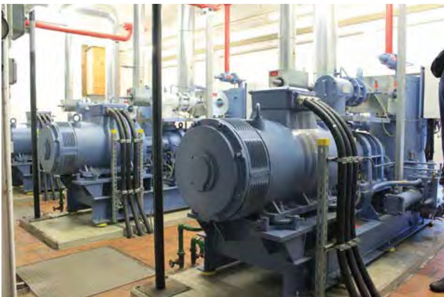
GEA vybavila Veltins-EisArena Winterberg třemi kompresory GEA, každý s chladicím výkonem 315 kW, a „sušičkou“ čpavku (Foto: GEA)
