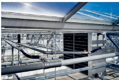
Obrovská pevnost ocelových trubek a lisovaných spojů Megapress umožňuje uložení potrubí s minimem pevných bodů pod stropem haly. (foto: Viega)
