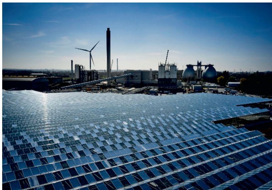
Částečný pohled na hybridní elektrárnu Emscher se skleněnými halami na sušení čistírenských kalů v popředí. (foto: Viega)
