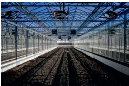
Některé haly na sušení čistírenských kalů, postavené jako skleníky, jsou dlouhé přes 160 m, v prostřední uličce dokonce přes 200 m. (foto: Viega)
