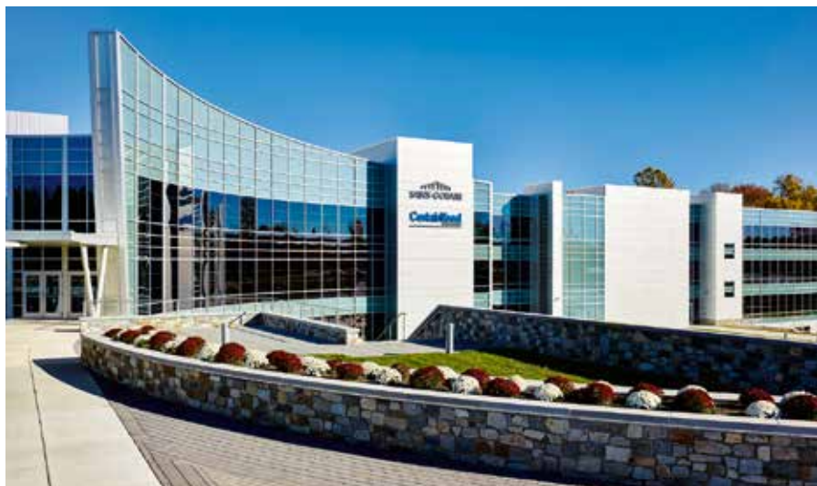
Budova dnešnej centrály Saint-Gobain pre Severnú Ameriku bola kolaudovaná ešte v 60. rokoch minulého storočia, no citlivou a efektívnou rekonštrukciou sa dostala až na úroveň LEED Platinum.
