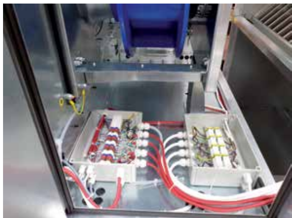
Príklad vyhotovenia elektroinštalácie jednotiek DUOVENT® MODULAR
