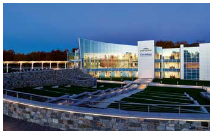
Vybrané plochy v exteriéri pri hlavnom vchode sú zavlažované. Zavlažovací systém využíva zozbieranú dažďovú vodu, čím sa zo zavlažovania úplne vylúčila pitná voda.
