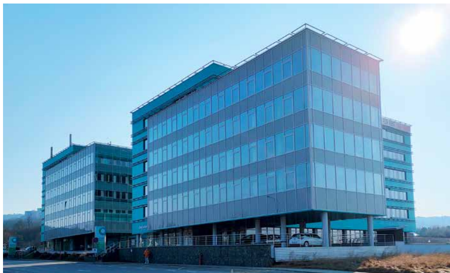
Obr. 1 Posudzovaná zelená administratívna budova
