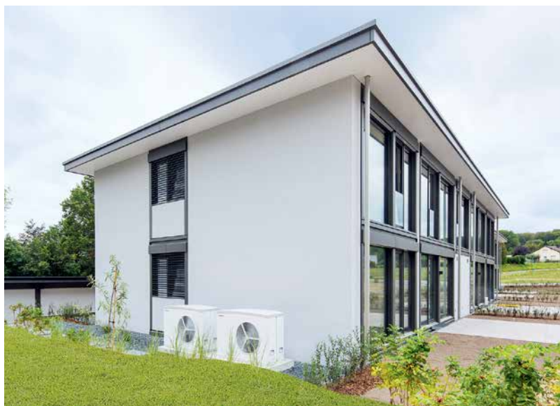
Modulárne riešenie stavebných častí výrazne zjednodušilo zabudovanie efektívnych technológií.
