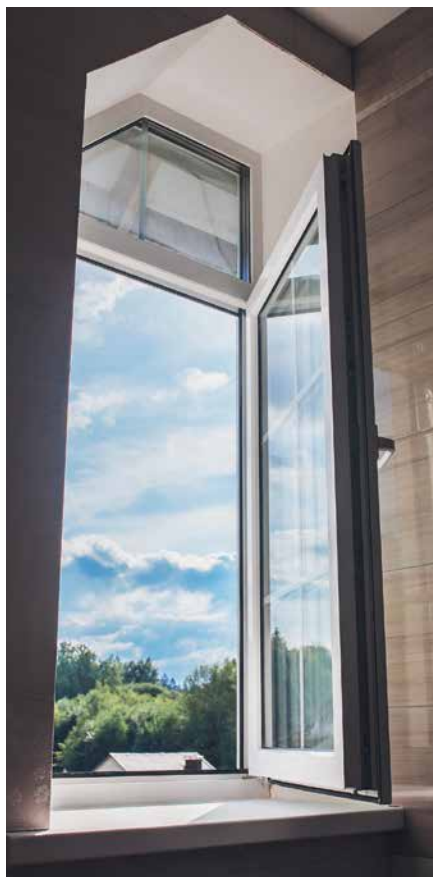
Vetraním oknami sa do bytu dostávajú prachové častice a peľ, ktoré by inak mohli byť odfiltrované v rekuperačnej jednotke riadeného vetrania.
