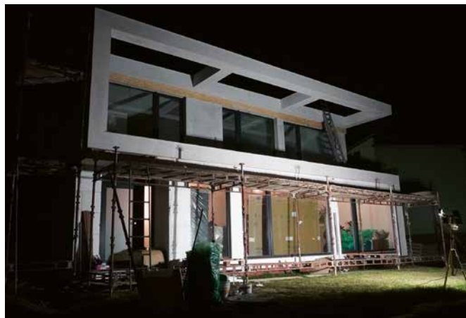
Práce na fasáde
