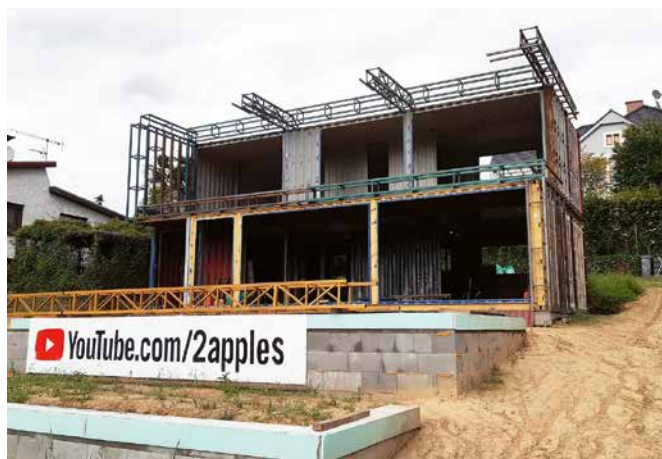
Príprava krytia terasy
