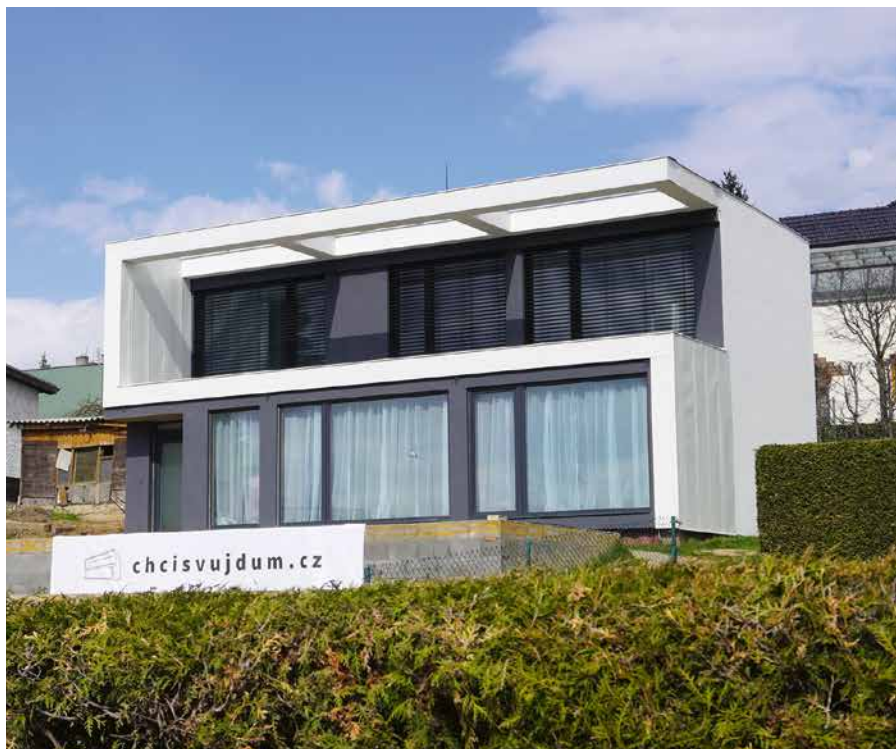
Pohľad na hotový dom
