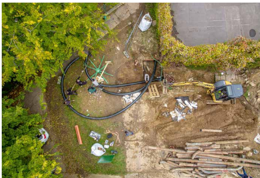
Vŕhanie flexibilných plastových potrubí do existujúceho kanála, realizácia v Bratislave
