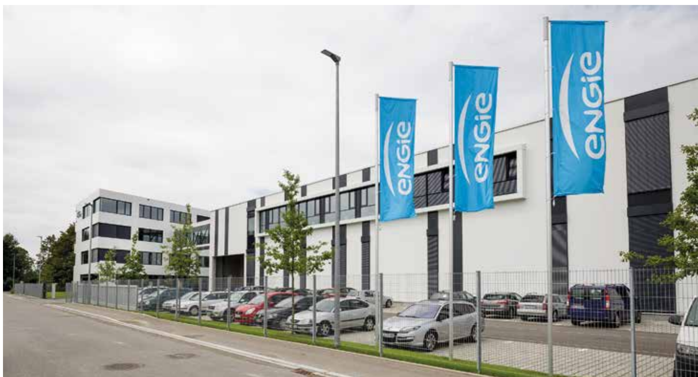
Nové sídlo společnosti ENGIE Refrigeration v Lindau a. B.
