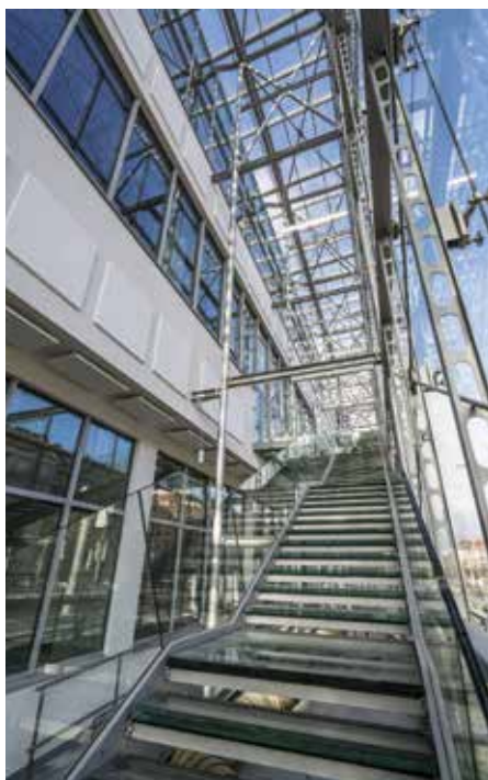
Celoskleněná konstrukce obvodové stěny budovy B představená směrem do třídy Jugoslávských partyzánů vrací revitalizovaný objekt do uliční čáry, vytváří meziprostor pro požární únikové schodiště, má nesporně příznivý vliv na onitřní mikroklima budovy v zimě a chrání před dopravním hlukem foto © archiv ČVUT v Praze
