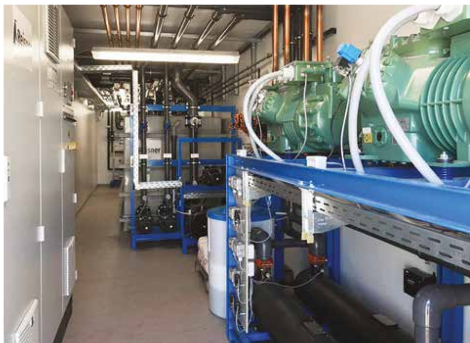
Reisner dodal celou chladicí technologii včetně příslušenství v dvanáctimetrovém kontejneru. V popředí: dva pístové kompresory BITZER, každý s chladicí kapacitou 96 kW
