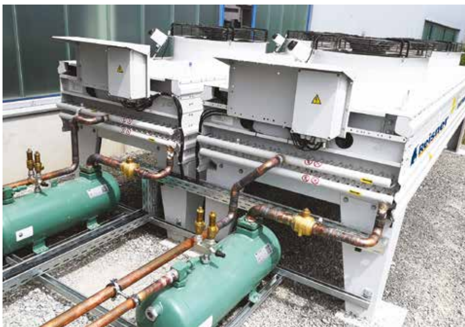
Díky EC ventilátorům pracují kondenzátory obzvláště tiše „Foto: Reisner Cooling Solutions GmbH“
