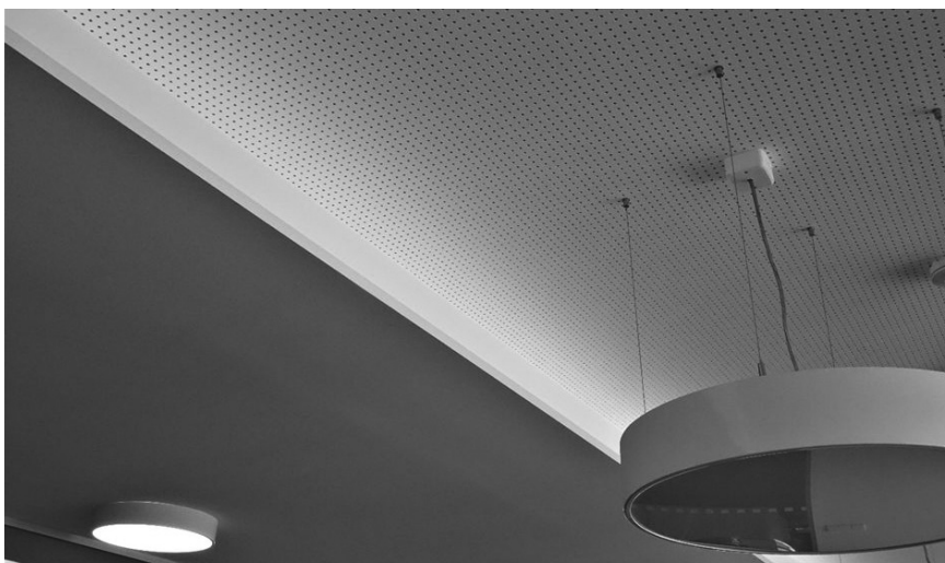
Topení na stropě v praxi. Inovacím v tepelné technice věříme, a proto je sami používáme.
