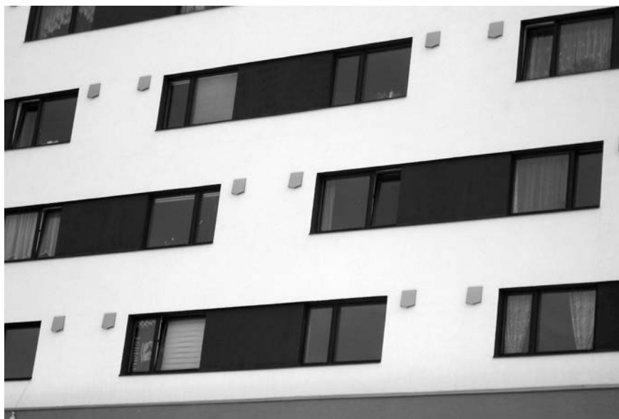
Bytový dům s instalovanými decentrálními rekuperačními jednotkami
