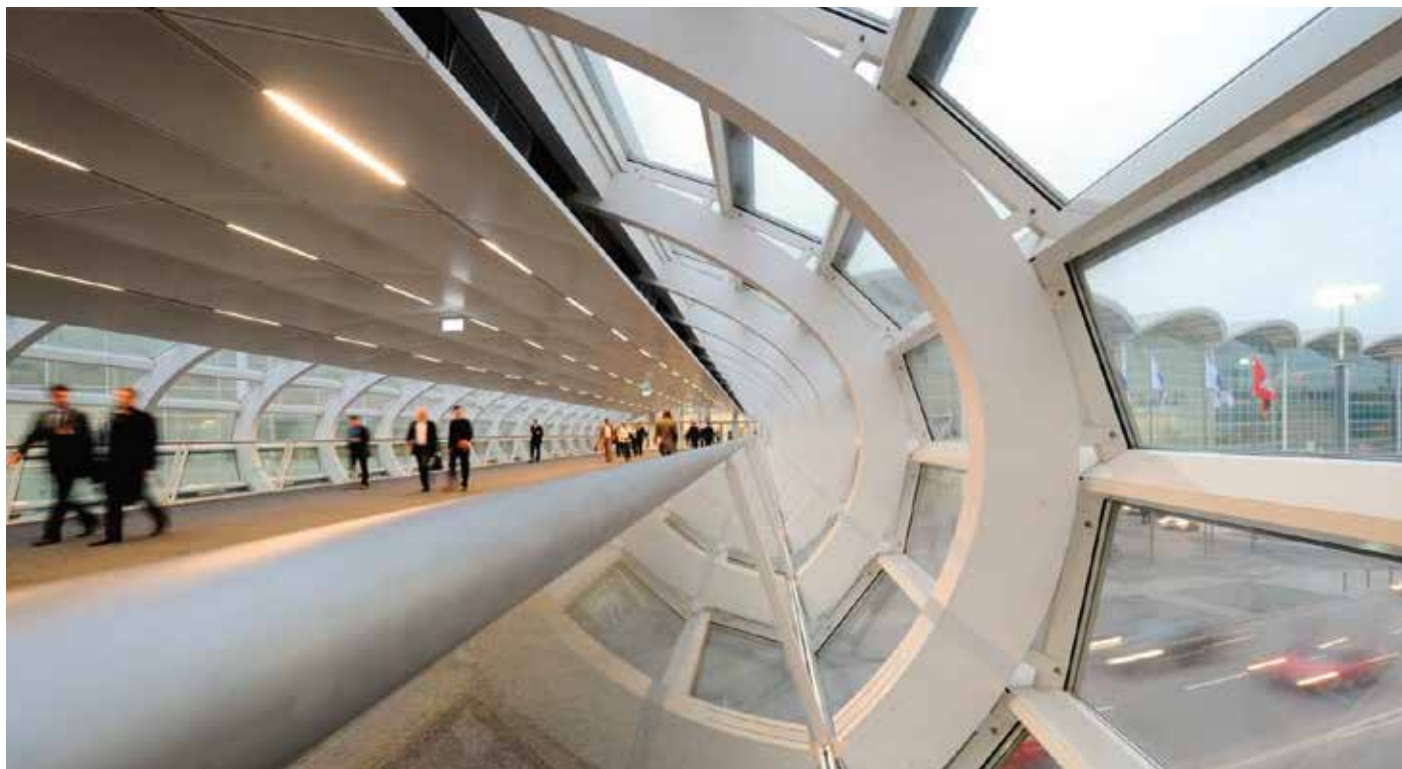
Skywalk Übergang zwischen den Messehallen A und B, přechod mezi ovetřnými halami A a B, © Hamburg Messe und Congress / Michael Zapf
