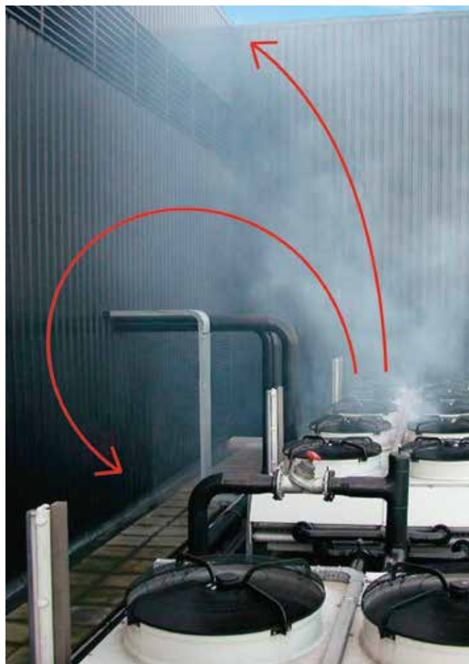
Obr. 3: S pomocí uměle vytvořené mlhy mohlo být prokázáno, že v této prostorové dispozici v závětrří za vysokou zdí budovy se vzduch vyfukovaný z výměníku částečně vrací a je spodem přísáován zpět do výměníku (Abb3_Aufstellungssituation.jpg)
