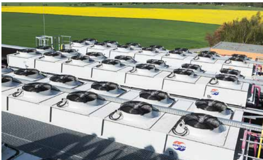
Kondenzátory Güntner FLAT Vario typu AGVH s výkonem 595 kW/2030 MBTU/h každý jsou kouřlí přísným hygienickým předpisům pro povolení staoby, předepisujícím dovolenou úroveň hluku v daném místě (baubehörlichen Schallvorgaben), konstruovány jako speciální přístroje a vykazují hladinu akustického tlaku 50 dB(A) ve vzdálenosti 10 m (33 ft) pro každý kondenzátor / Foto Güntner (Gt_TK_Backwaren_7)
