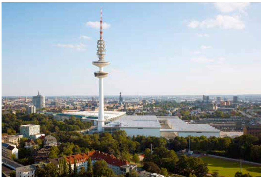
Letecký pohled na novou veletržní areál Hamburg Messe (Luftaufnahme_Neue_Messe_Hamburg.jpg), © Hamburg Messe und Congress / H. G. Esch, Ingenhoven Architects
