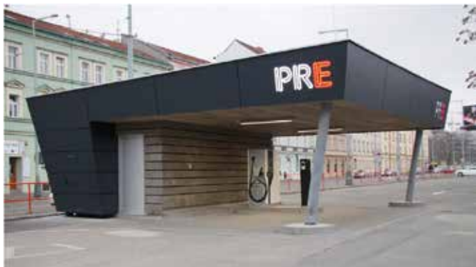
Nabíjecí stanice PRE v Holešovicích
