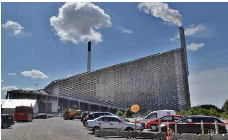
„Kodaňská spalovna Amager Bakke“
