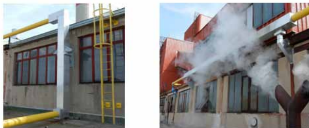
Obr. 1 Příklady vedení plynovodu v požárně nebezpečném prostoru
