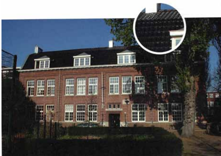
Tento bytový dům v Rotterdamu byl pokryt 3000 fotovoltaickými taškami firmy ZEP BV. Systém má výkon 27 kilowatt
