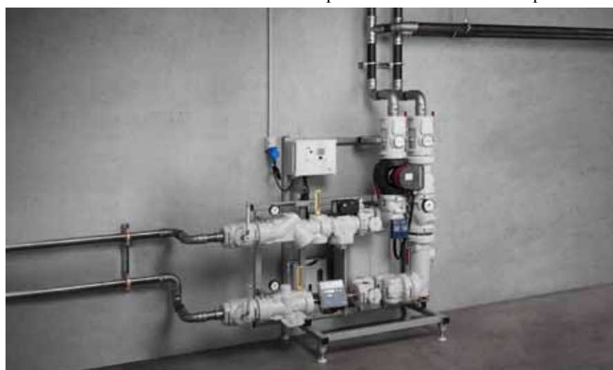
Nový spojovací systém Megapress S v rozměrech 3/8 až 2 palce se skvěle hodí pro dálkové i lokální rozvody tepla uvnitř budov. (foto: Viega)
