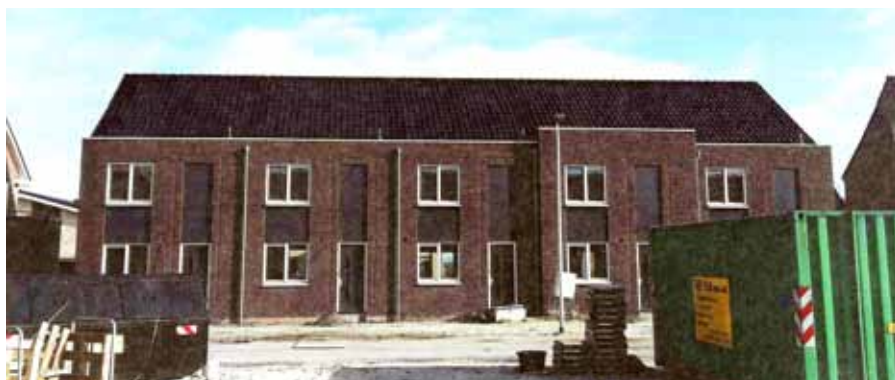
Střeška těchto řadových domů v Holandsku je doplněna 198 taškami firmy ZEP
