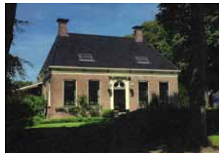
Tento dům je pod památkovou ochranou, proto nebylo jiného řešení než tašky se solárními moduly
