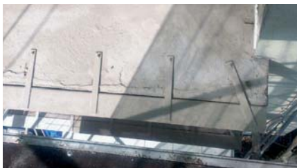
Sanace původního panelu a konstrukce pro rozšíření
