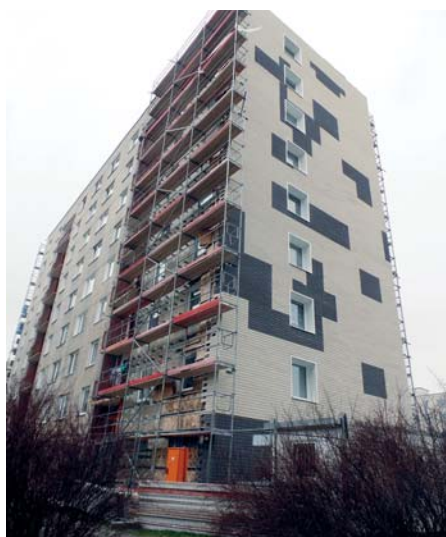
Štít panelového domu zateplený systémem Scanroc
