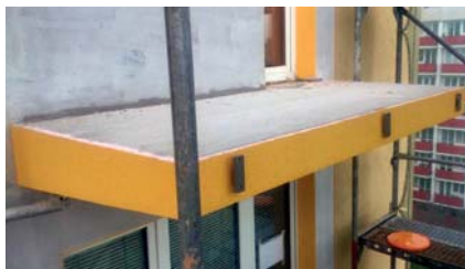
Vybetonování nové spádové vrstvy
