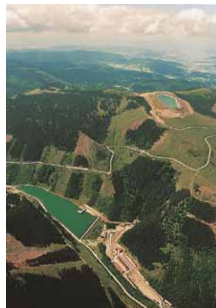
Největší přečerpávací vodní elektrárnou v ČR jsou Dlouhé Stráně (foto ČEZ)
