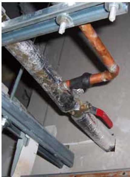
Obr. 9 Oprava měděného potrubí
