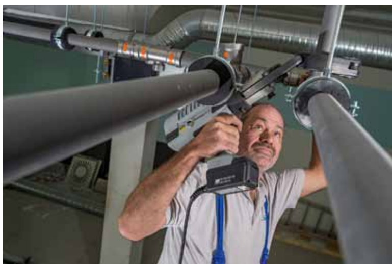
Lisování místo svařování: Doba montáže spojovací technikou je poloviční, práce nad hlavou nebo na úzkých místech jsou bezproblémové – a je vyloučeno riziko požáru
