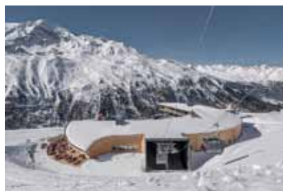
Nová kabinová lanovka v Timmelsjochu vyvází návštěvníky na úchvatné vyhlídky a sjezdovky. V kabinách vyznačují příjemné teplo vyhřívané sedačky, v budově pak rozvod tepla zajišťují potrubní systémy firmy Viega (Foto: Top Mountain Crosspoint/ Alexander Maria Lohmann 2016)
