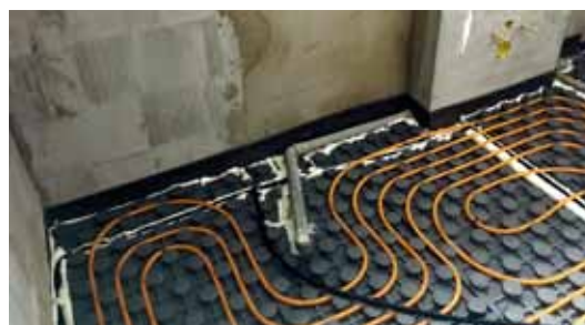
Finalizace koupelny před betonáží (teplá voda dimenze 17 mm bez izolací nad podlahovým topením)
