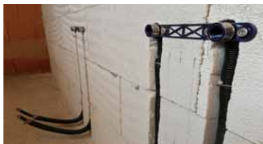
Osazení přípojů do zdi
