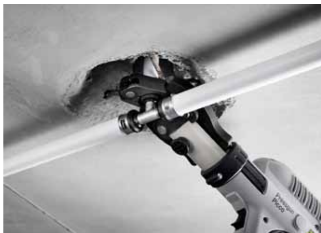
Spojky Viega Smartpress s příslušnými lisovacími prstenci mohou být bezpečně lisovány i na těžko přístupných místech nebo přímo pod stropem
