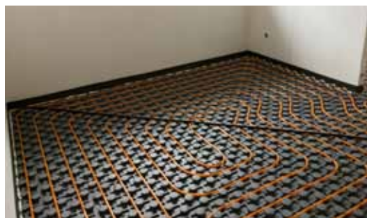
Připojení teplé vody od boileru nejkratší trasou (bez izolací)
