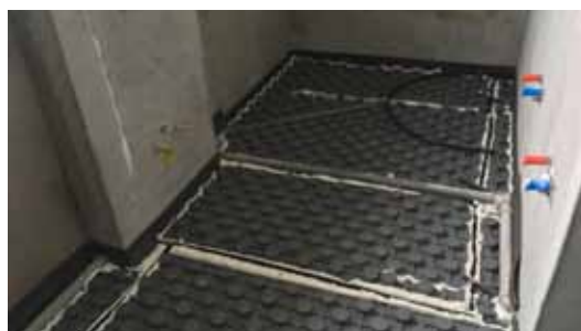
Koupelna před instalací podlahové trubky
