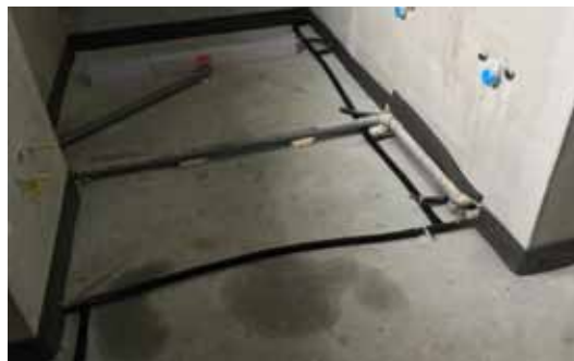
Studená voda izolovaná nebo pod izolací
