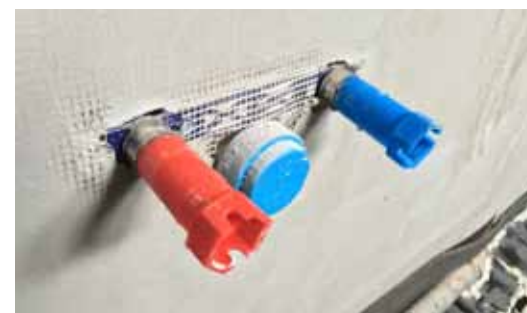
Vodovodní nástěnka po omítkách
