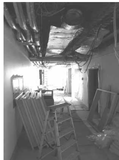
Obr. 4 Ukázka prostorové náročnosti instalace vzduchotechniky (VZT jednotka vlevo, potrubní rozvod pod stropem vpravo)
