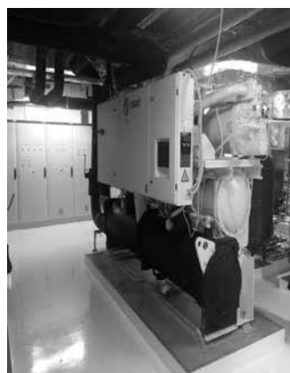
Obr. 5 Ukázka prostorové náročnosti výrobku studené vody s rozdělovačem a sběračem
