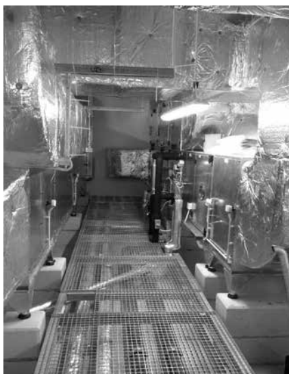
Obr. 4 Ukázka prostorové náročnosti instalace vzduchotechniky (VZT jednotka vlevo, potrubní rozvod pod stropem vpravo)
