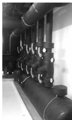
Obr. 5 Ukázka prostorové náročnosti výrobku studené vody s rozdělovačem a sběračem
