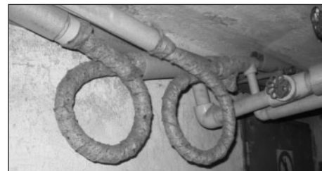
Obr. 5 Kompenzační smyčky ve vodorovném potrubí
