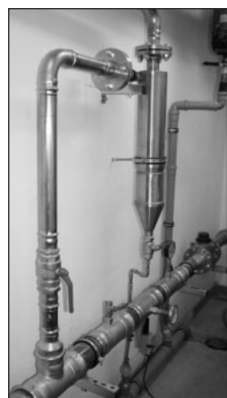
Obr. 13 Výměňňková stanice - zařízení „nacpané“ do kouta
