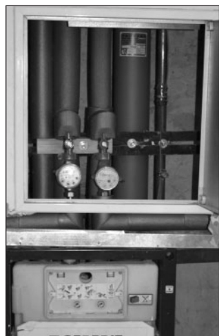
Obr. 8 Upevnění potrubí v bytovém jádru
